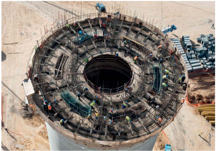
Les chutes en hauteur, le plus souvent mortelles, sont les principaux accidents constatés dans le BTP
