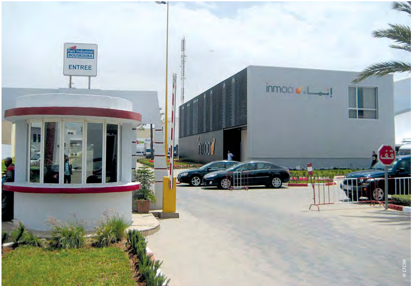
Entrée du parc industriel CFCIM de Bouskoura
