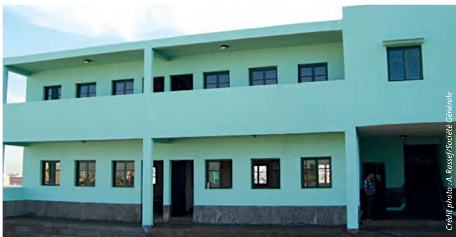
Le nouveau bâtiment du collège Touria Sekkat signé Initiatives
