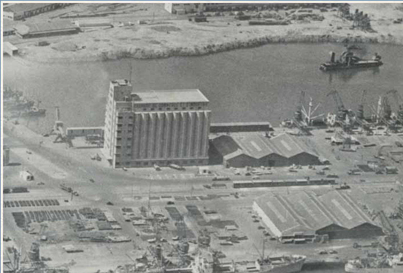
L'édifice des docks-silos de la CCIC
