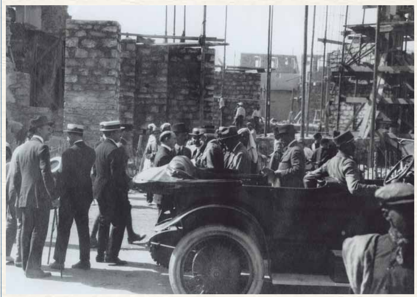
Chantier de la Bourse du Commerce
